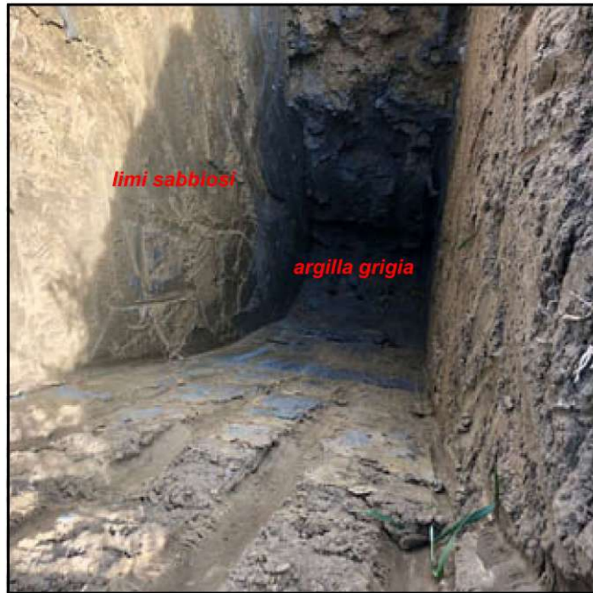
foto scavi per installazione piezometri: si noti l'assenza di acqua negli scavi. Prof. fondo scavo: 6 m dal p.c.
