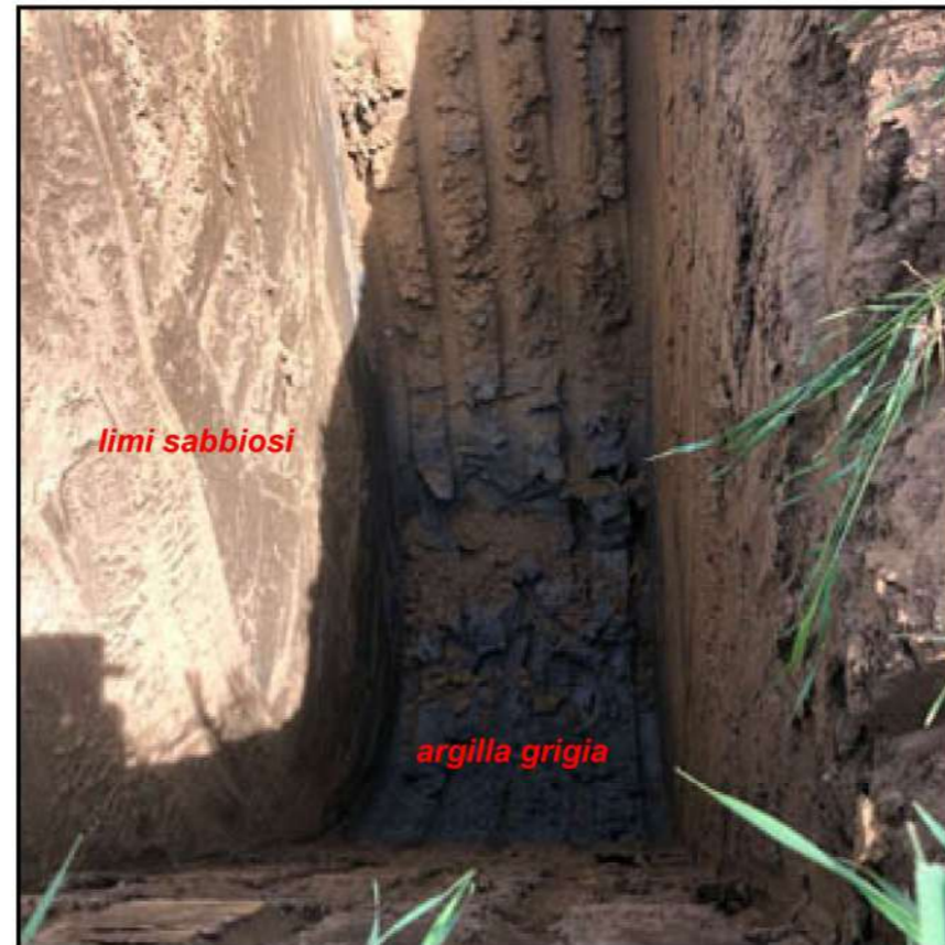
foto scavi per installazione piezometri: si noti l'assenza di acqua negli scavi. Prof. fondo scavo: 6 m dal p.c.
