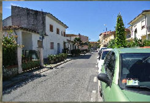
Da v. Gramsci a v. Triano la piattaforma stradale è caratterizzata da una corsia di marcia pari a 3.85 m e da sosta in linea di 2 m. Si elimina la sosta presente (9 stalli +3 moto) e si realizza percorso ciclabile promiscuo nel senso di marcia e pista ciclabile con sola segnaletica nel verso opposto secondo quanto previsto dalla nota del Ministero prot. 6234 del doppio senso "limitato" alle bici.
