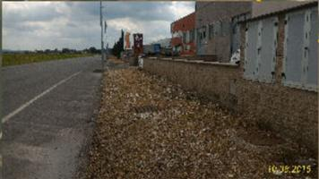
La sezione della piattaforma stradale è caratterizzata da valori inferiori a 8 m incluse le banchine. Occorre la tombatura dei fossi su entrambe le direzioni di marcia per una lunghezza pari a ca. 185 m sul lato sinistro nella direzione v. Livornese est e ca. 200 m sul lato destro. Sul lato sinistro per 60 m è possibile proseguire il percorso nell'ampia banchina esistente avente una larghezza di 1,5+4,66 m
