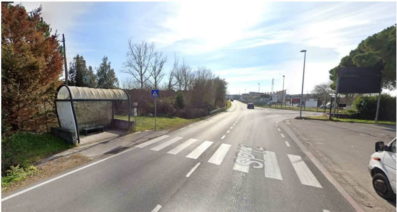
Figura 16 - Fermata sulla SP12 in prossimità dell'intersezione con via Sicilia
