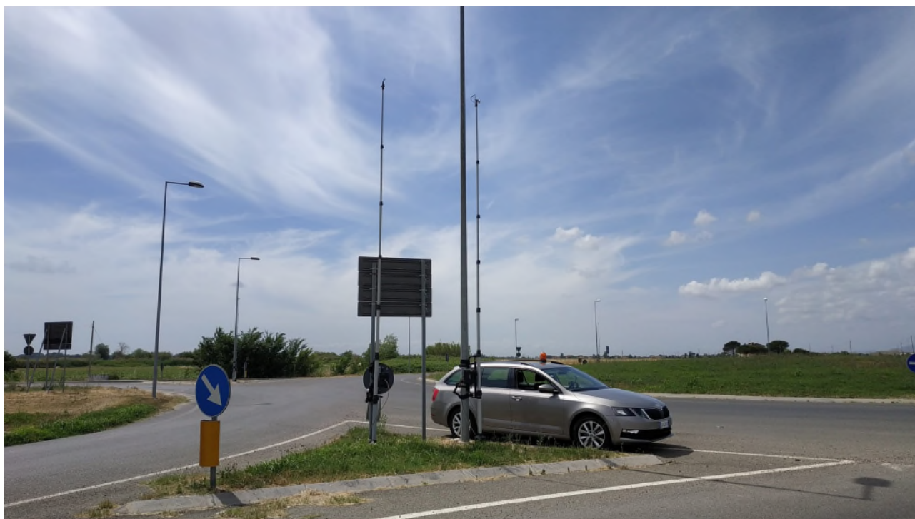
Figura 20 – Nodo N2, dispositivi video nell'intersezione Sicilia/Arginello/Pieranacci
