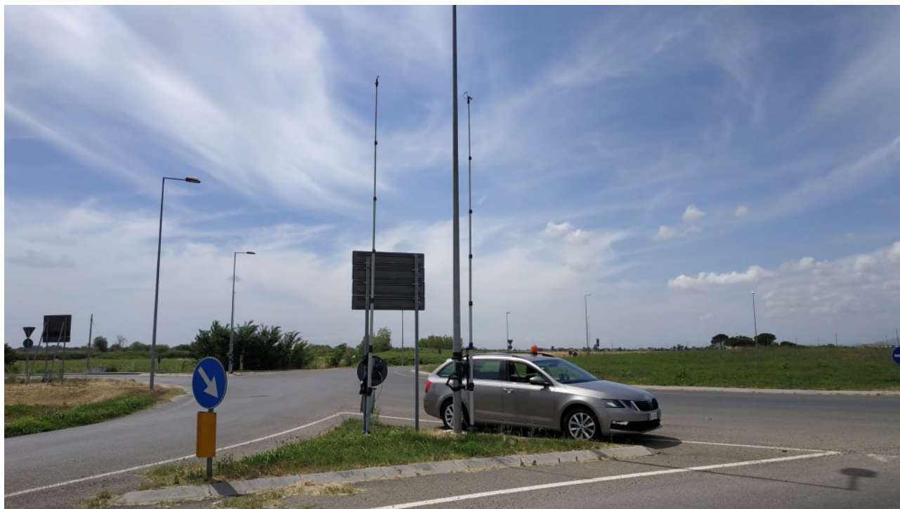
Figura 20 – Nodo N2, dispositivi video nell'intersezione Sicilia/Arginello/Pieranacci
