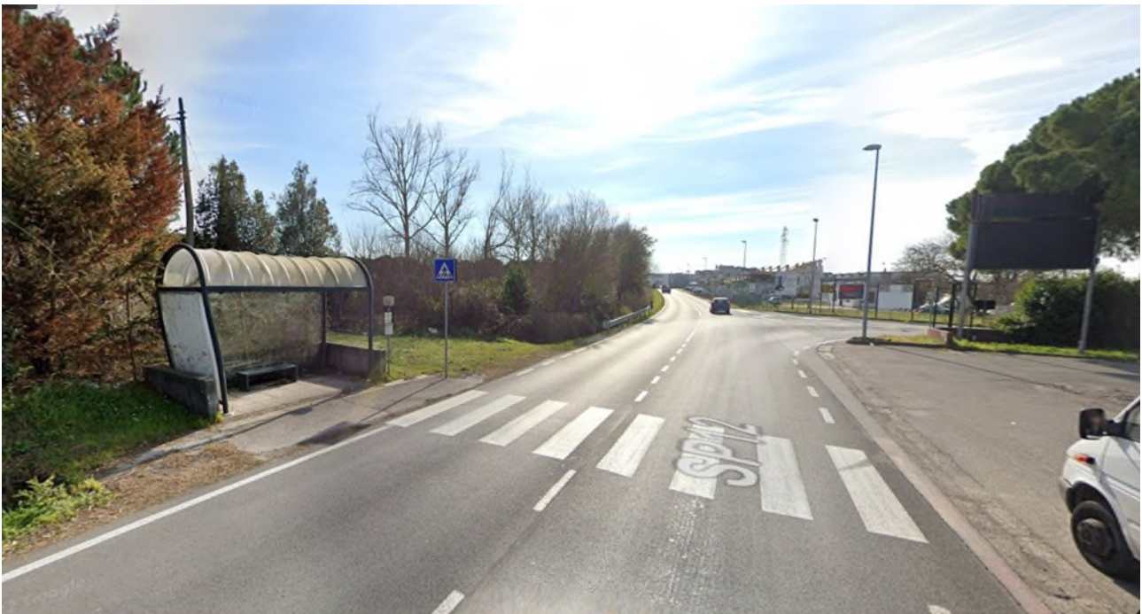
Figura 16 - Fermata sulla SP12 in prossimità dell'intersezione con via Sicilia
