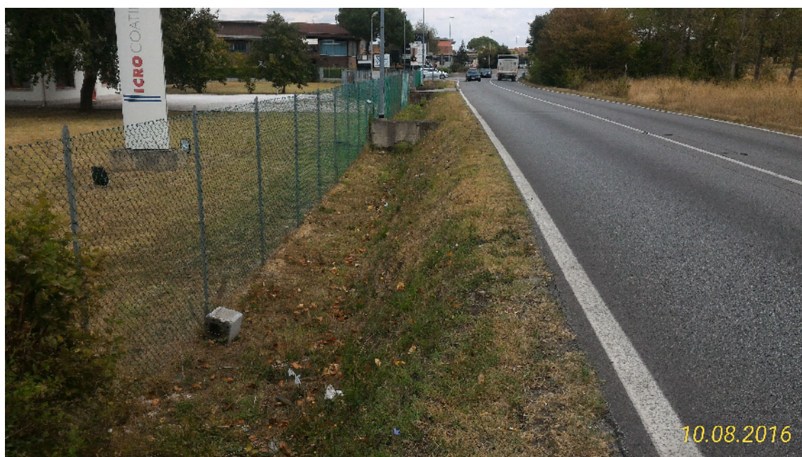
Fig. 40 - Il fosso ad elevata profondità
